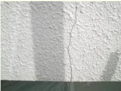
下塗り塗装前の外壁塗装面。
