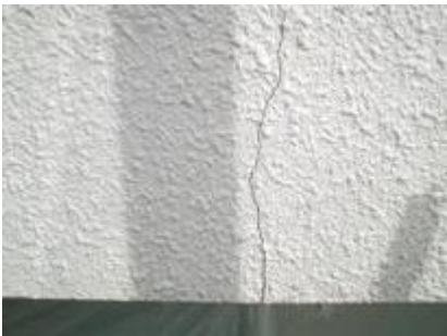
下塗り塗装前の外壁塗装面。
