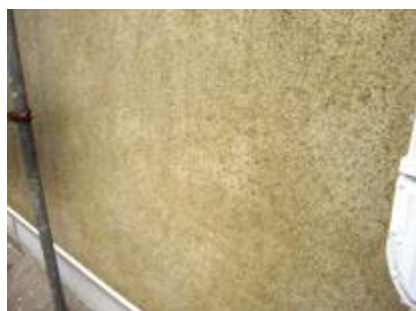
高圧洗浄前の外壁塗装面。
