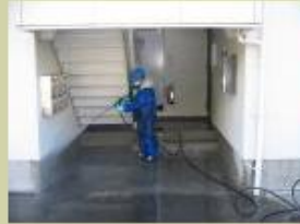
コンクリート(モルタル)
